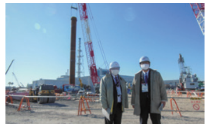
▲東海第二発電所（東海村）では、津波の流入を防ぐ防潮堤（高さ20メートル、全長約1.7キロ）の設置工事が進んでおり、状況を視察しました。安全対策の着実な進捗と、県民への丁寧な説明を、強く要請しました。（R2.12.23）
