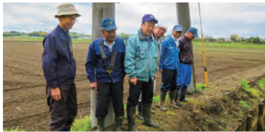
▲土師地区の田んぼの排水路の損壊箇所を関係者と現地調査。現場主義を貫きたい。(H31.4月)
