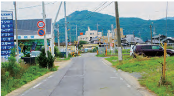
▲踏切が狭いため、車の相互通行になっている。危険を一刻も早く解消したい。(R1.7月)
