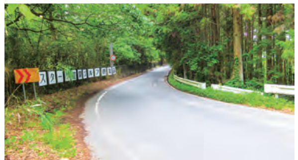
▲真端水戸線は水戸方面への通学、通勤道路として重要な道路だ。地元の皆様の強い改良要望を受けている。着実に進めたい。(R1.7月)
