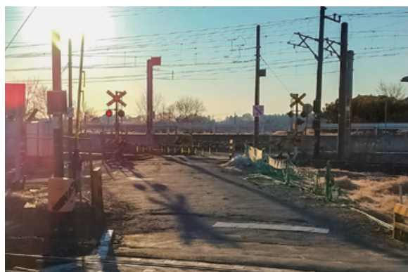
朝日のまぶしさ対策として遮断棒にヒラヒラが垂らされた。(事故から22日後の事故と同時刻の午前8時頃)
