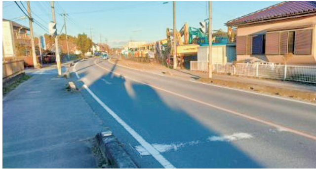
▲手前の停止線は消えかかっている。対向車線の停止線と横断歩道は完全に消えてしまっている。(R4.12月)
