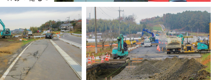
橋爪地区での県道大洗友部線の拡幅と濁沼川の河川改修工事
