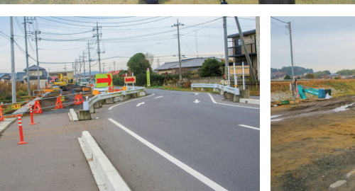
こころの医療センター前～友部IC間の拡幅工事
