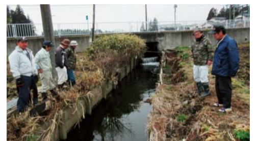
▲岩間支所近くの河川のり面崩壊改修の件で土師地区の役員の皆さんと。早速改修実現した。(平成27年2月)
