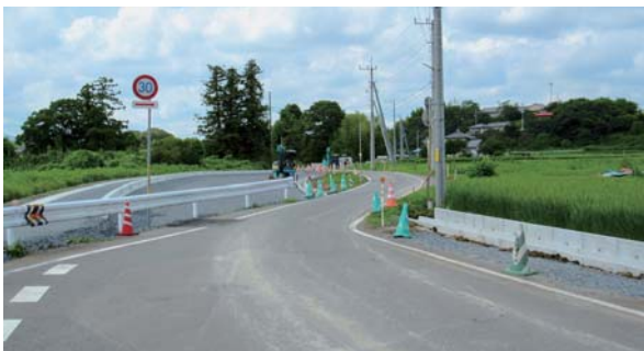
▲長年の懸案であった、狭くて危険な通学道路を解消するために、私が取り組んできた拡幅工事が進んでいる。「はなさか」下の県道大洗友部線。(H29年7月)
