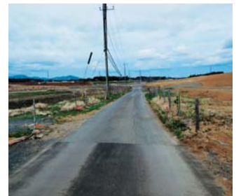
▲茨城中央工業団地(笠間地区)の造成が進む中、生活・通学道路である柏井~随分附の市道の拡幅整備が決定した。柏井区総会で報告した。(H28年3月)
