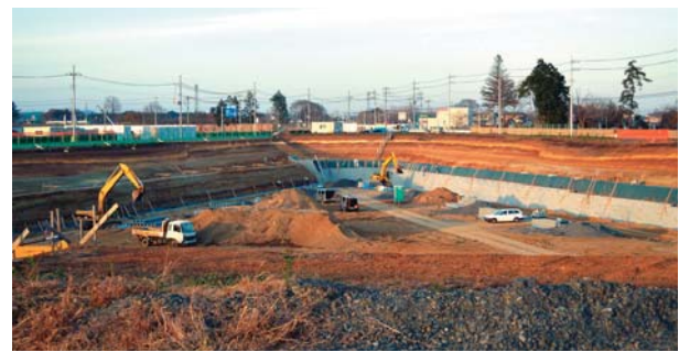
▲畜産試験場跡地で進む雨水排水事業の調整池造成工事。(平成27年12月)
