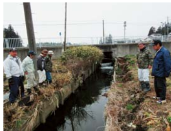
▲岩間支所近くの河川のり面崩壊改修の件で土師地区の役員の方々と。早速改修実現した。(H27年2月)
