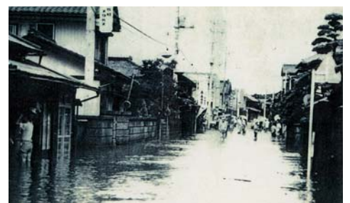
▲昭和61年8月5日、洶沼川増水による橋爪・平町地区の浸水状況。
