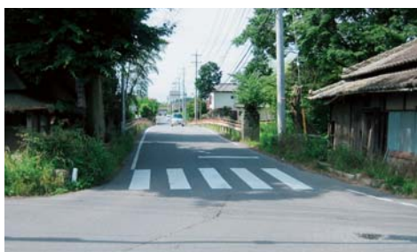
▲国道355号の老朽化した宍戸橋の架替えは、喫緊の課題である。(22年6月)
