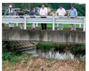
▲間黒川(寺崎、箱田地区)の土砂たい積状況を水戸土木事務所原部河川整備課長と調査。(22年7月)
