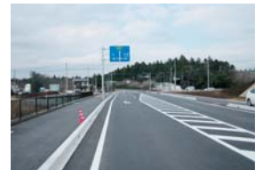
▲岩間IC—茨城空港間、第1期工事完成。(22年3月)
