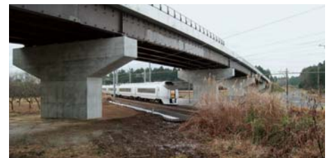
▲石岡岩間バイパスの常磐線をまたぐ東成井跨(こ)線橋
