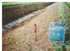
▲旧友部町上市原地区で、涸沼前川のたい積土砂の掘削と除草を実施した。(17年8月)
