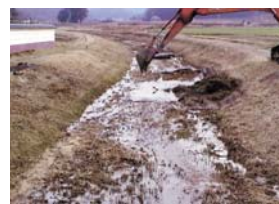
▲桜川市の桜川上流部の小塩地区でたい積土砂の掘削を実施した。(18年2月)
