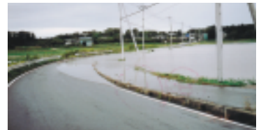
▲台風23号による風雨で冠水し、通行止めになった県道石岡常北線の酒沼川付近。常井議員も現地を調査した。岩間町下安居区の久保田運平区長さんからの要望を水戸土木事務所に伝え、早速かさ上げ改良をすることになった。(16年10月)
