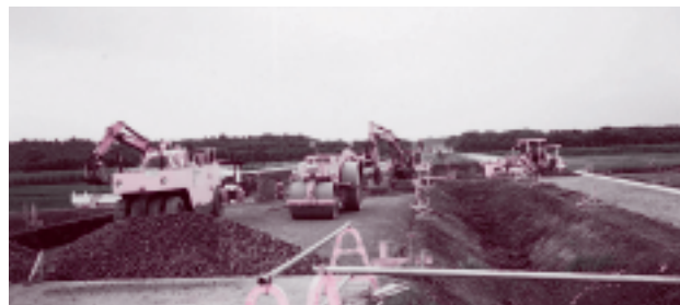
▲着々と工事が進む、355号岩間バイパス。常磐線跨線橋の設計にも着手した。
