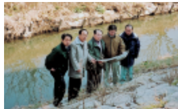
▲岩瀬町役場裏の桜川の護岸が崩れているため、水戸土木事務所の高須課長、町の入江建設課長さんと現地調査を実施した。その結果、早速改修することになった。常井議員の右隣りは、篠崎町議会議長さん。(15年2月)
