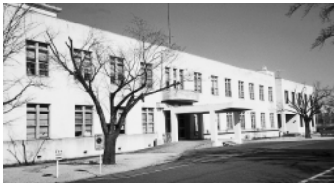
▲友部病院の管理棟。事務局・受付・診察室がある。昭和13年に霞ヶ浦海軍航空隊友部分遣隊が筑波航空隊として独立したとき、本部として建設されたものである。
