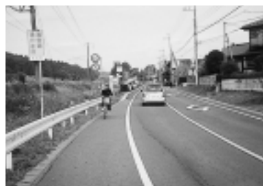
▲友部町松山団地の皆さんからの要望に基づき、太田町内県道のセイコマートこぼり店前から大工町踏切りまでの歩道と排水路の設置工事が実施された。小・中学生の通学の安全を願う地域の皆さんの熱意の成果であり、常井県議もご協力に感謝しております。(13年10月)
