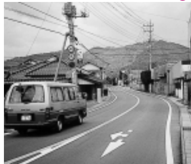
▲県道つくば益子線。岩瀬町元岩瀬地内の住民から、悪路による家屋の振動が激しいとの苦情が常井県議に寄せられた。早速、全面補修を実施しました。
